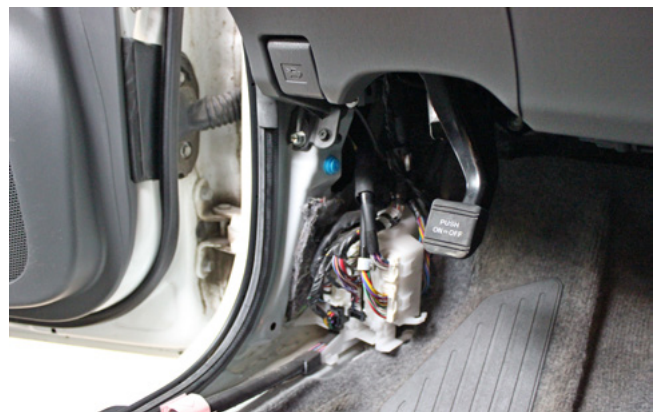
Фото 1.4. Накладка левой кик-панели снята
