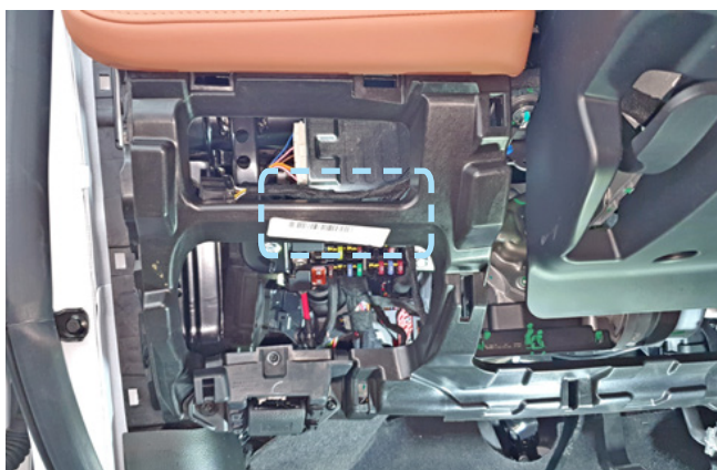
Фото 2.9. Пример расположения центрального блока охранно-телематического комплекса
