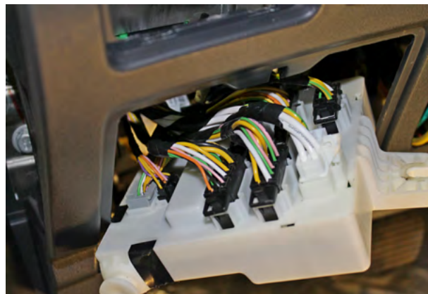
Фото 2.4. Монтажный блок предохранителей снят
