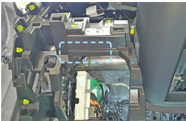
Фото 2.8. Пример расположения центрального блока охранно-телематического комплекса
