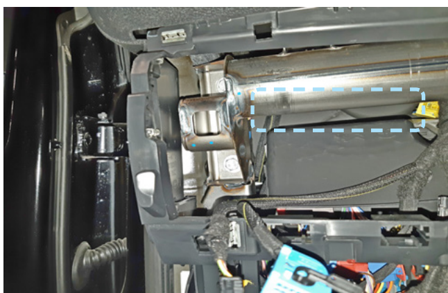
Фото 2.8. Пример расположения центрального блока охранно-телематического комплекса
