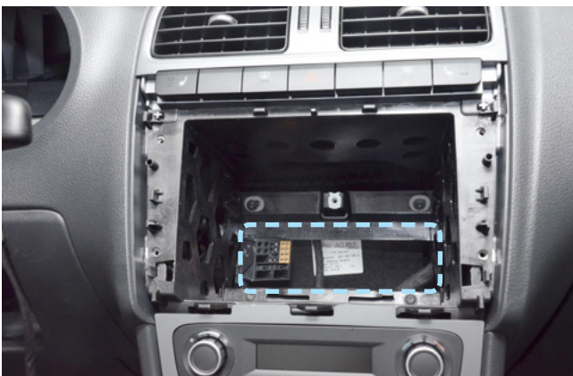
Фото 2.8. Пример расположения центрального блока охранно-телематического комплекса
