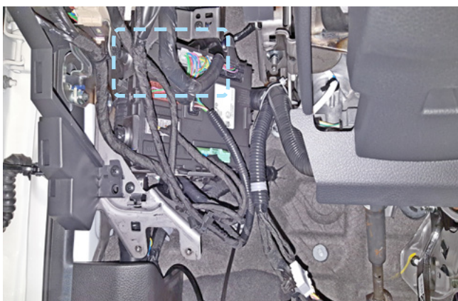
Фото 2.9. Пример расположения центрального блока охранно-телематического комплекса
