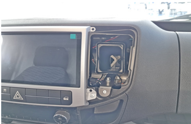
Фото 1.3. Правый центральный воздухопровод снят
