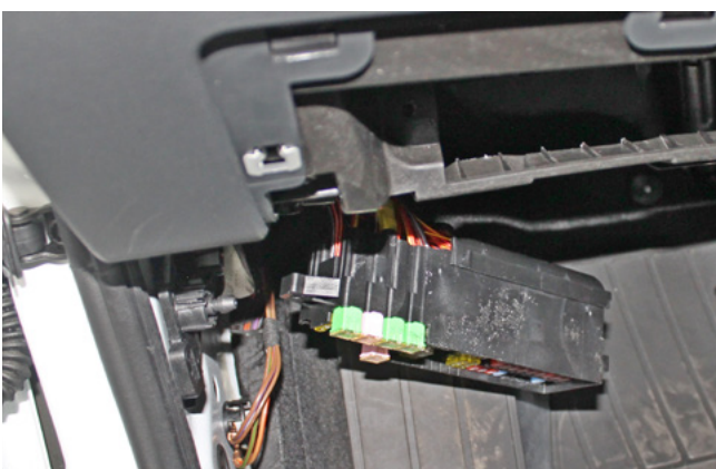
Фото 1.16. Блок предохранителей снят
